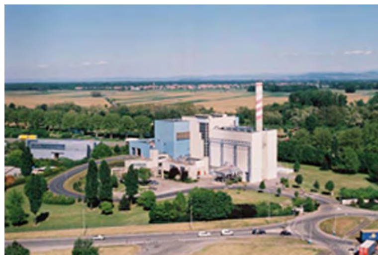
Usine de traitement des déchets de Colmar
