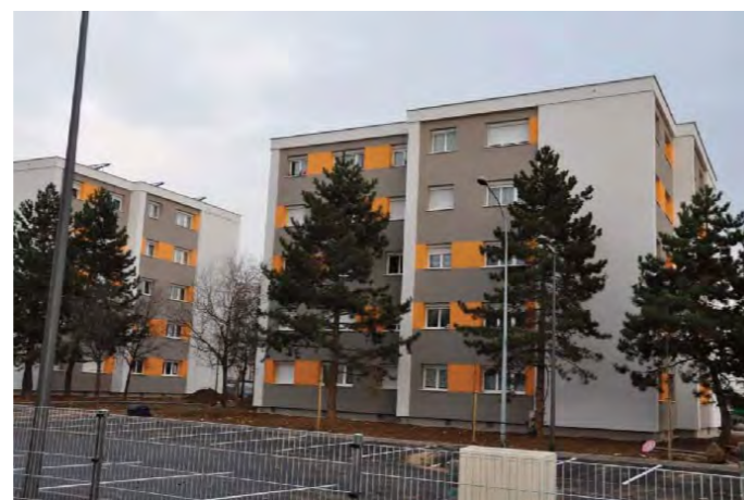
Réhabilitation (BBC) Palais Royal à Colmar
